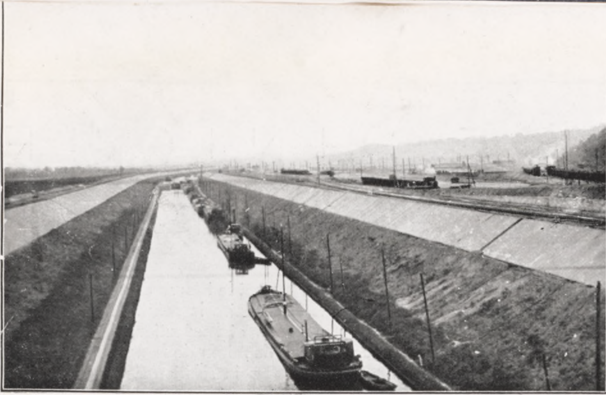
Fig. 200. Aspect du chantier Haccourt-Briegden. L'ancien canal entre les nouvelles berges.
