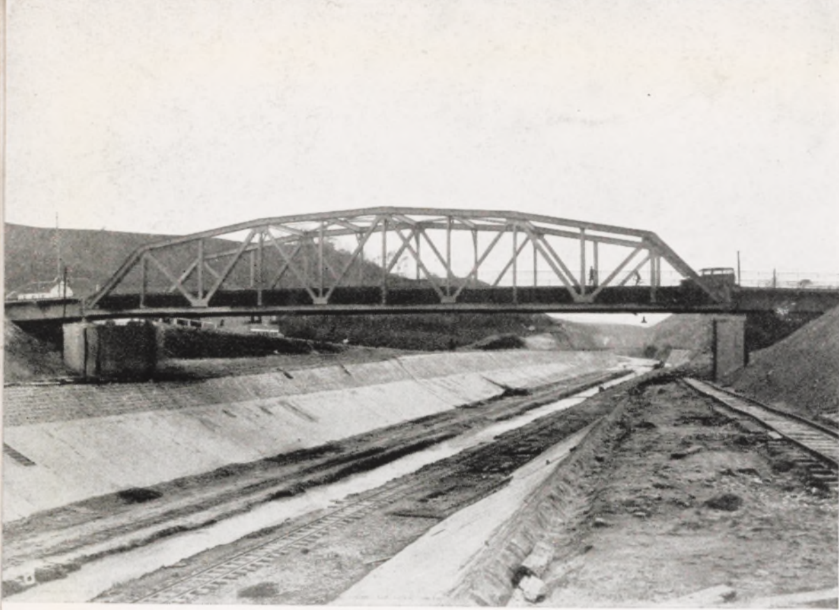
Fig. 190. Pont de Canne.
