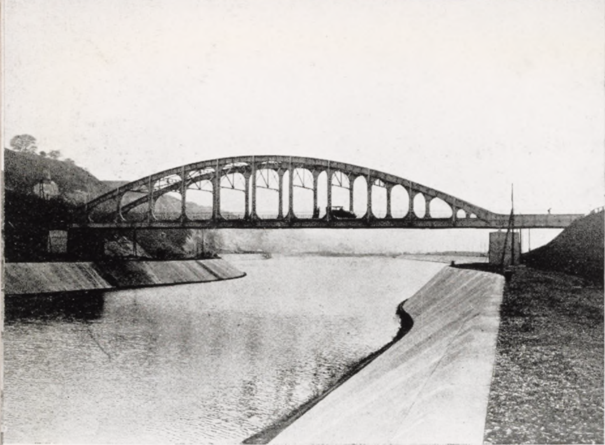
Fig. 194. Pont de Lanaye.
