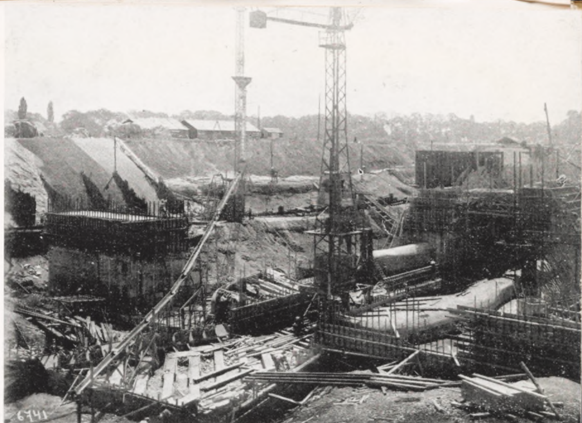
Fig. 189. Ecluse de Neerhaeren.
