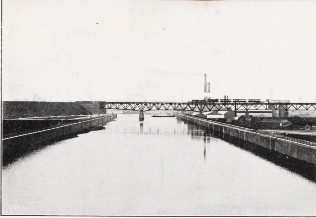
Fig. 196. Haccourt. Pont de Visé.
