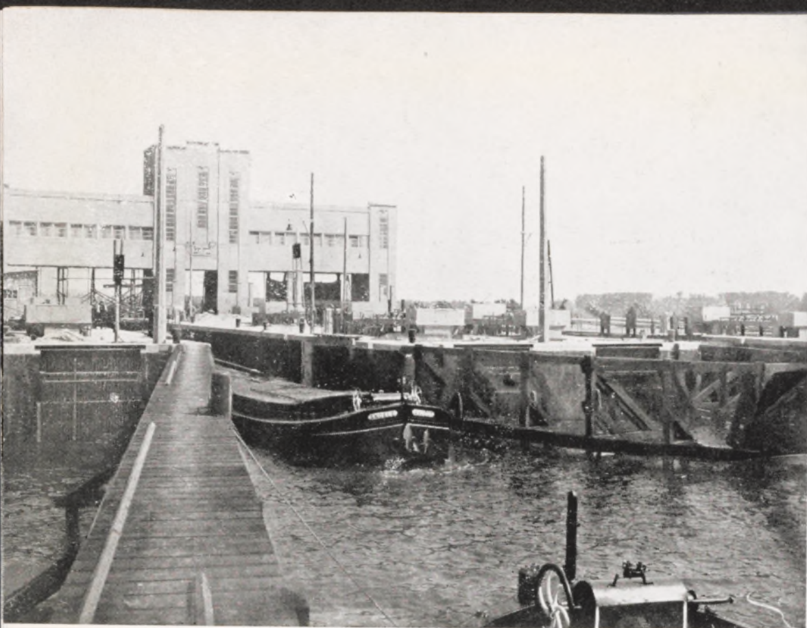
Fig. 198. Ecluse de Lanaye; chute de 14 mètres.
