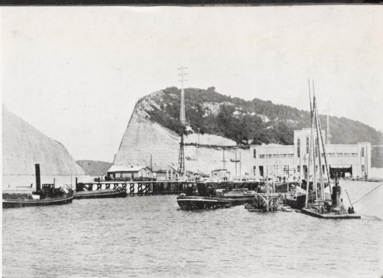
Fig. 199. Ecluse de Lanaye et entrée de la tranchée de Caster.
